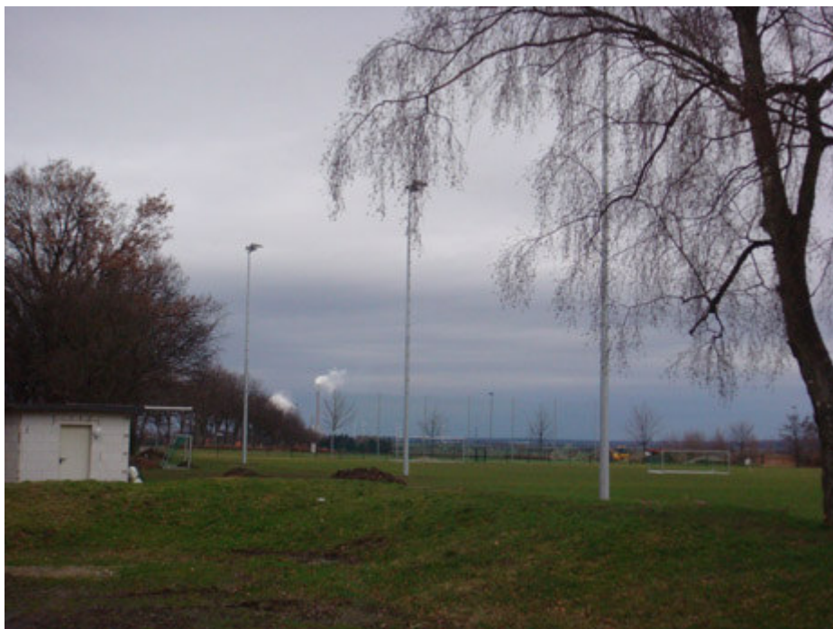
Die neue Beleuchtungsanlage auf den Hauptplatz des TSV Hohenhameln erreicht eine Beleuchtungsstärke von 130 Lux. Alle Bilder: IBR Flutlicht GmbH
