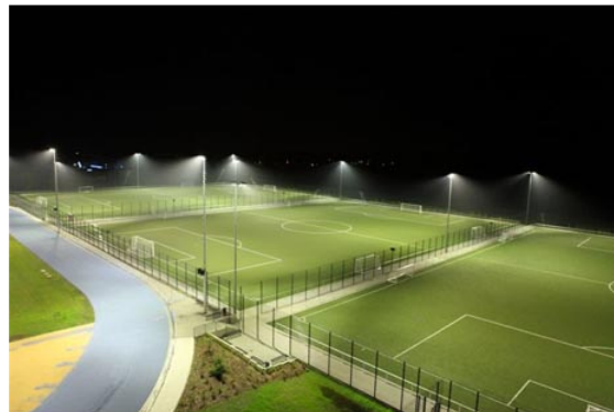
Bei dem Sportzentrum Rosenzentrum in Falkensee konnten die Masten aufgrund der parallelen Anordnung der Sportfelder gleich mehrfach verwendet werden Beide Bilder: IBR-Flutlicht GmbH
