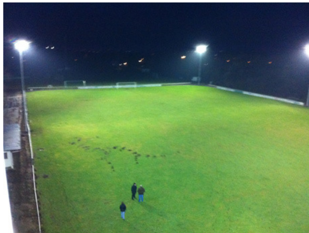
Ein Blick vom Eckmast der neuen Beleuchtungsanlage in 16m-Höhe
