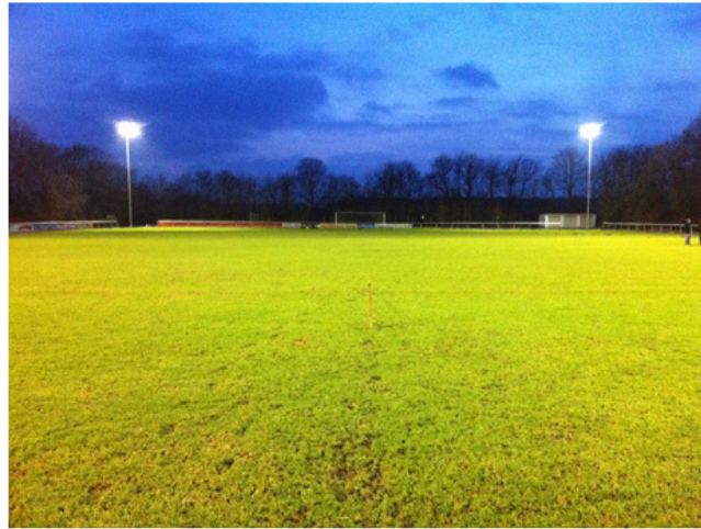
Die Eckmasten der neuen Beleuchtungsanlage Alle Bilder: IBR Flutlicht GmbH
