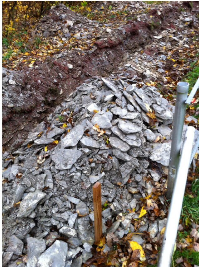
Hier sind die Erdkabelgraben zu sehen, ein Bodenaustausch war notwendig
