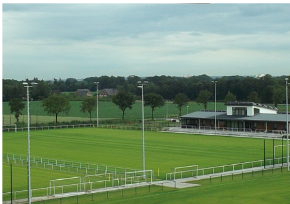
Die IBR Flutlicht GmbH und das Ingenieurbüro Rößler haben Planung und Umsetzung der Beleuchtungsanlage des 50.000 Quadratmeter großen PIAS-Sportparks übernommen. Alle Bilder: IBR Flutlicht GmbH
